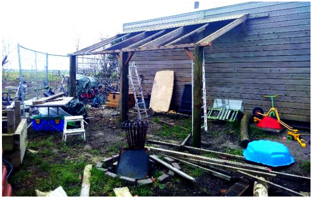
Schuurtje in aanbouw, volledig van hergebruikt hout van de oude schuur
