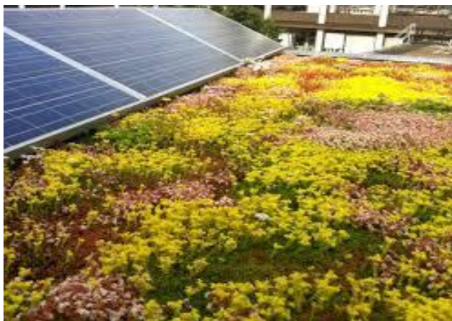
een sedum dak met zonnepanelen
